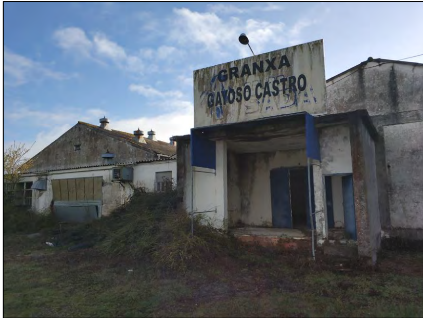
Imaxe 2: Estado actual das instalacións
