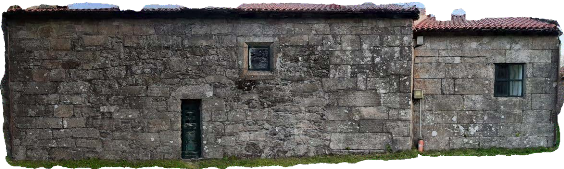
Iglesia de Santa María de Fecha, fachada S sobre la que los estudiantes realizarán el trabajo de identificación de Ues
